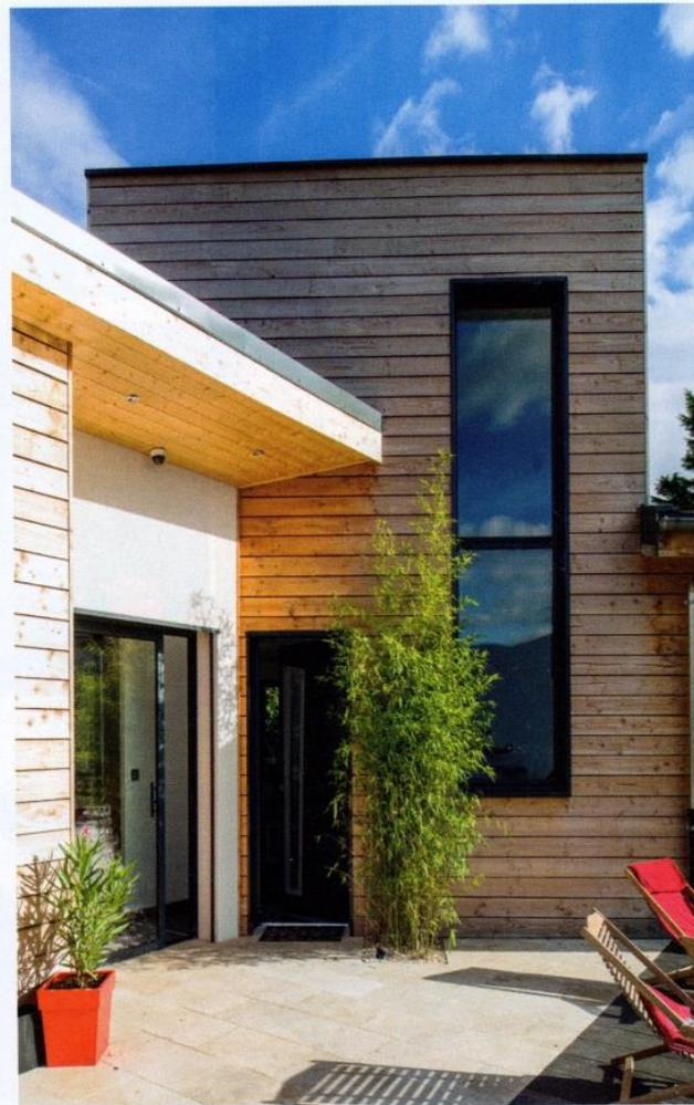
**Parements extérieurs.** Le revêtement extérieur est principalement un bardage en douglas laissé brut. Les parties basses de la construction et les contours de l'entrée sont en enduit.
