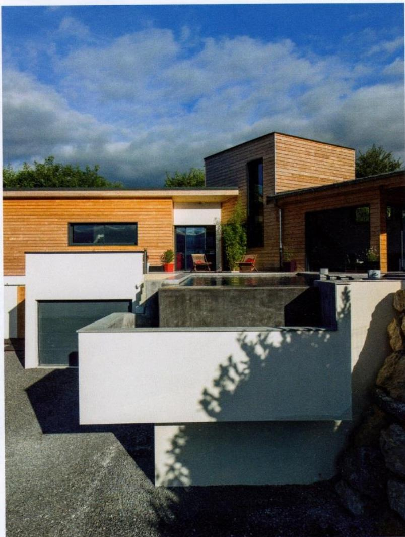
**Liaison routière.** Relier le garage à la route, plus haute, a nécessité de gros travaux de terrassement ainsi que des enrochements pour faire face aux contraintes de la forte pente du terrain.
