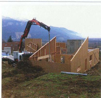
**04** La cage d'escalier béton (servant à contreventer la structure) émerge des panneaux du rez-de-chaussée. Elle servira également à emmagasiner de la chaleur pour un confort intérieur optimal.
