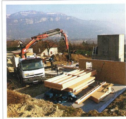
**03** Les panneaux bois préfabriqués par le charpentier (structure en pin douglas) sont livrés sur le chantier et dressés les uns après les autres à l'aide d'un camion-grue.
