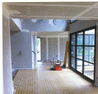
**15** Dans le salon, face à la cuisine et à la salle à manger, l'entrée est à gauche. Au sol, pose d'un isolant pour plancher-chauffant à eau qui sera relié à une pompe à chaleur air-eau.
