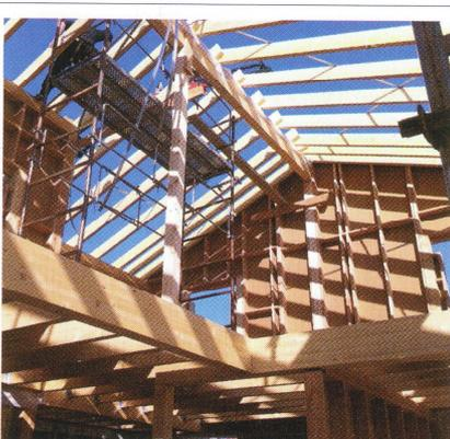
**08** Vue en contre plongée depuis la salle à manger avec sa double hauteur. La charpente en chevrons porteurs est posée sur les poutres prêtes à recevoir les tuiles en terre cuite.
