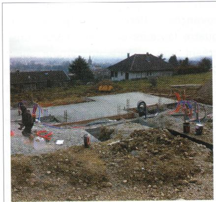
**02** Les réseaux d'eau et d'électricité sont intégrés dans la dalle béton du niveau bas. Ce dallage est coulé au contact du sol (principe du terre-plein) pour diminuer les pertes thermiques du plancher bas.
