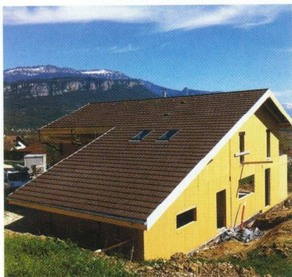
**11** L'isolation est en fibre de bois est posée en double couche croisée dans les murs. Ce type d'isolation procure un déphasage trois fois plus important qu'un isolant classique (laine de verre).
