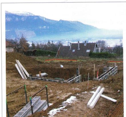
**01** Afin d'optimiser le terrassement sur ce terrain en pente légère (10% en amont et 5% en aval), une cave a été installée au sous-sol de la maison. Les banches de béton armé assoient la structure.
